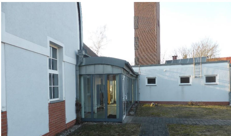
Abb. 35 Turnhalle Kirchstraße: ungenutzte Solarthermieanlage
