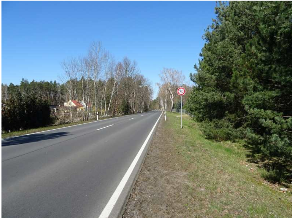
Abbildung 4: Blick auf die angrenzende Bundesstraße B 2 aus südlicher Richtung
